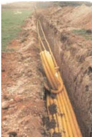
Pose de drains qui recueillent l'eau en excès.
